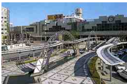
札幌駅北口駅前広場
