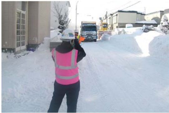
図 5-9 女性の従事者の労働環境の向上につながる取組 建設業人材確保・育成支援事業（女性の働きやすさをサポート） 女性の作業服・安全帯・ヘルメットなどの装備品購入費の一部を助成
