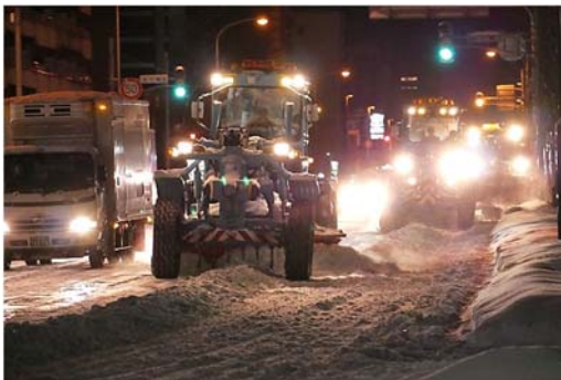
幹線道路の除雪
