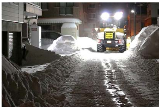
生活道路の除雪
