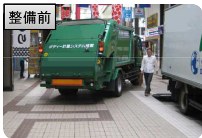
整備前 点字ブロックがない状態。 車両通行時は歩行者と錯綜。
