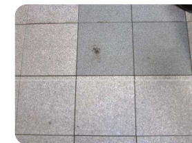
整備後の舗装面
