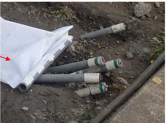
注入完了後に管を閉塞し、地表面より50cm程度で切断し撤去を行う
