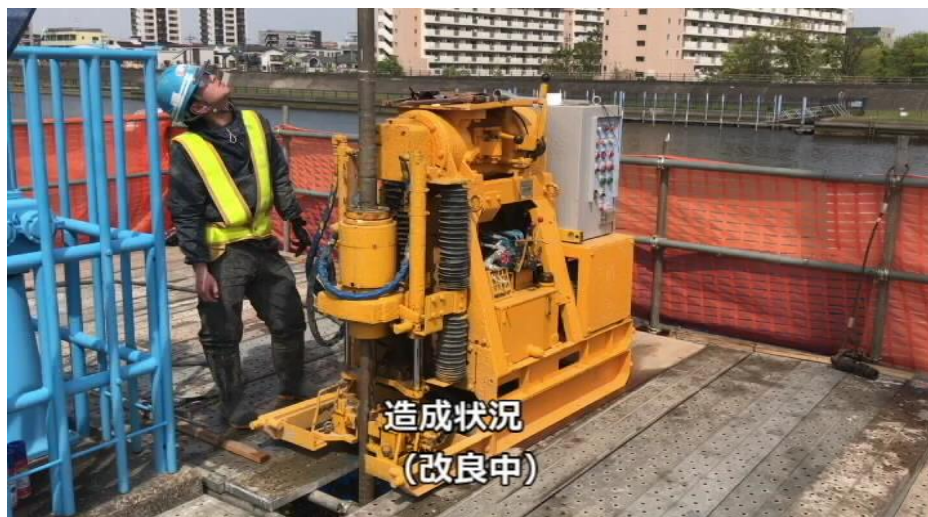
③ 深層混合処理（高圧噴射）の状況
