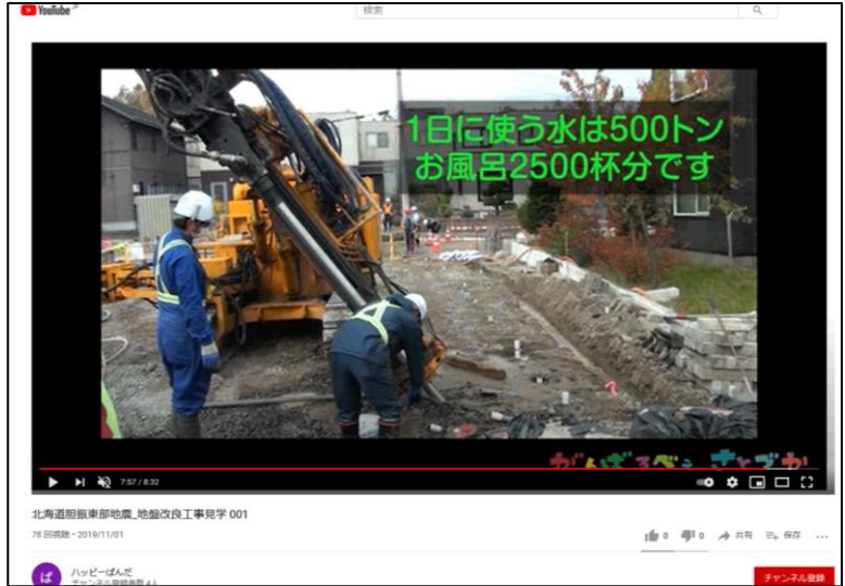
地盤改良について 住民からの質問に施工業者が回答
