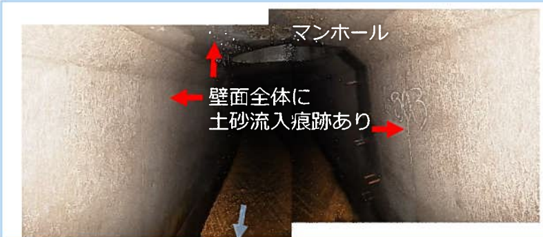
写真③ マンホール付近
