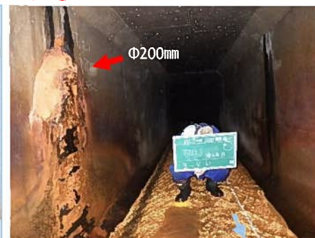
写真⑥ 暗渠排水の接続
