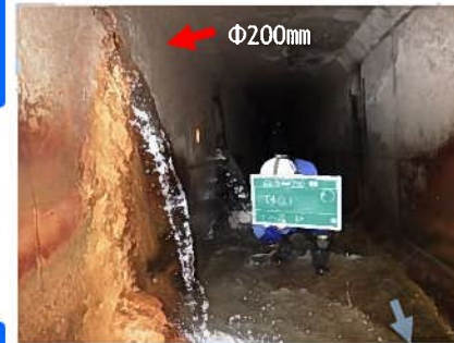
写真① 暗渠排水の接続
