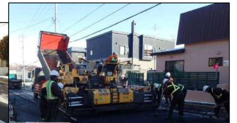
・仕上げ舗装を施工している様子
