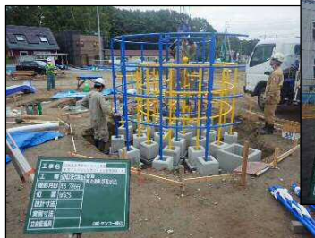
↓遊具を設置している様子
