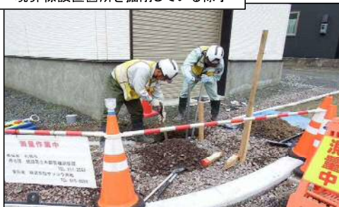
・境界標設置箇所を掘削している様子
