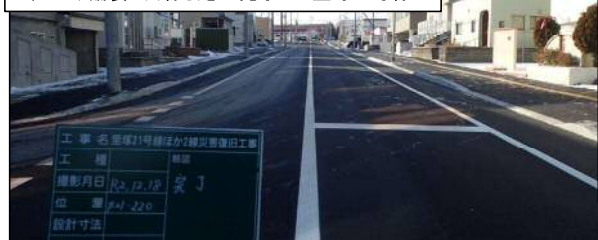
・仕上げ舗装と白線引きが完了した里塚21号線
