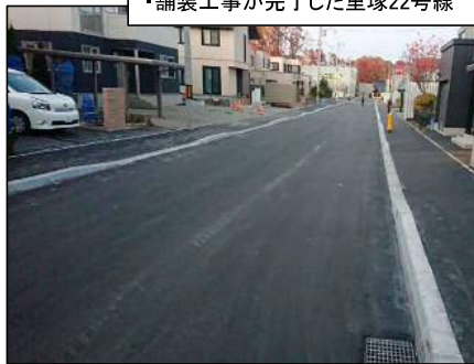
・舗装工事が完了した里塚22号線
