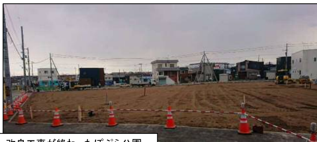
改良工事が終わったぽぷら公園
