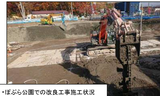
・ぽぷら公園での改良工事施工状況 ※(手前)中層混合処理工法 (奥)砂利の埋め戻しによる置換工
