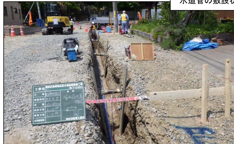
水道管の敷設状況
