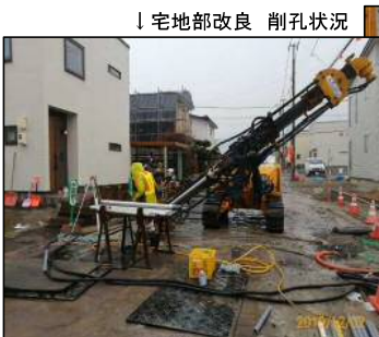
↓宅地部改良 削孔状況
