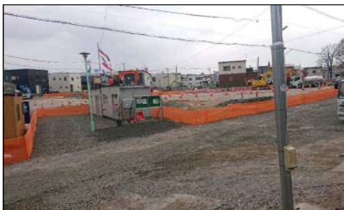
→ 万能塀撤去中の様子
