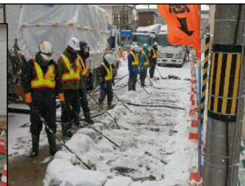
↑宅地部改良 薬液注入
