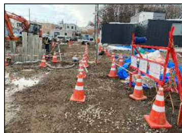
「作業終了後の仮囲いの様子 ※道幅が狭くなっております」
