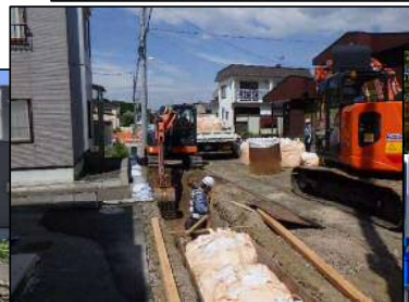
↑ビット掘削状況
