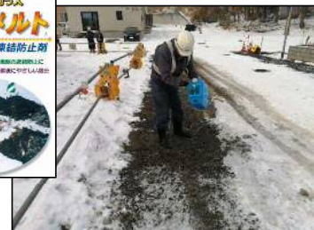
← 融雪剤を散布して凍った土を溶かしています
