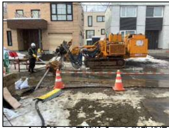
1号線での薬液注入工の削孔状況 2/13撮影
