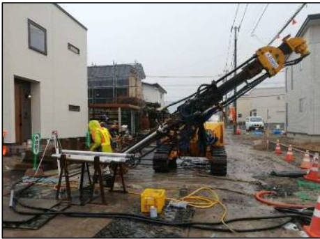
→ 23号線②での施工状況
