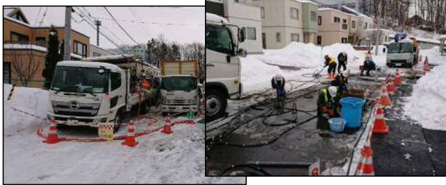
1号線での薬液注入工の注入状況 2/19撮影
