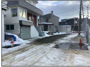
↑注入パイプ埋戻し後の 23号線②の様子
