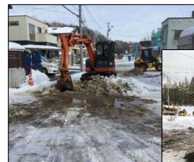
↑わだちとなった積雪を除去
