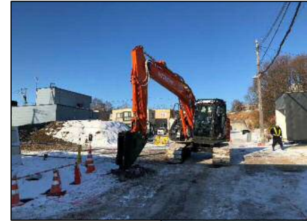
←ブレーカーを装着したバックホウ ※先端の刃で凍った土を砕きます
