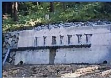
地下水排除工
