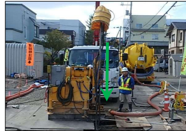
←①削孔状況 ドリルを掘下げます
