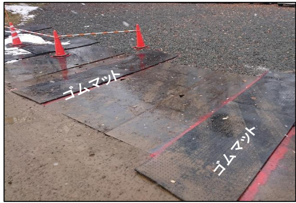
↑ ゴムマット敷設と滑り止め砂散布による転倒防止対策を実施しました
