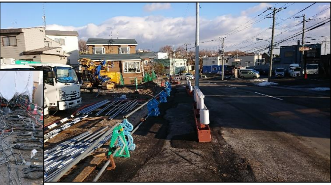
←このように歩道上にホースが横断します (マット等で段差解消を行います)
