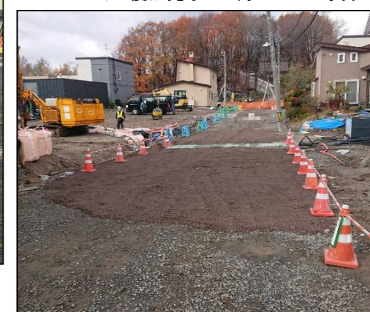
↓ 復旧完了 11月12日 10時頃
