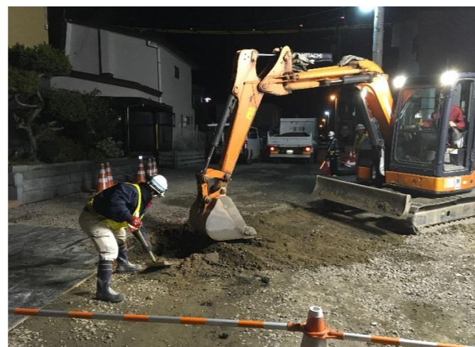
陥没箇所の復旧作業状況↓
