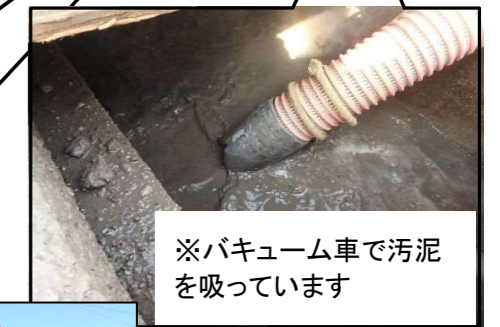
※汚泥が跳ねないように カバーをしています
