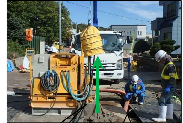
②造成状況→ ドリルを上げます ※見た目はほとんど 変わりませんが…
