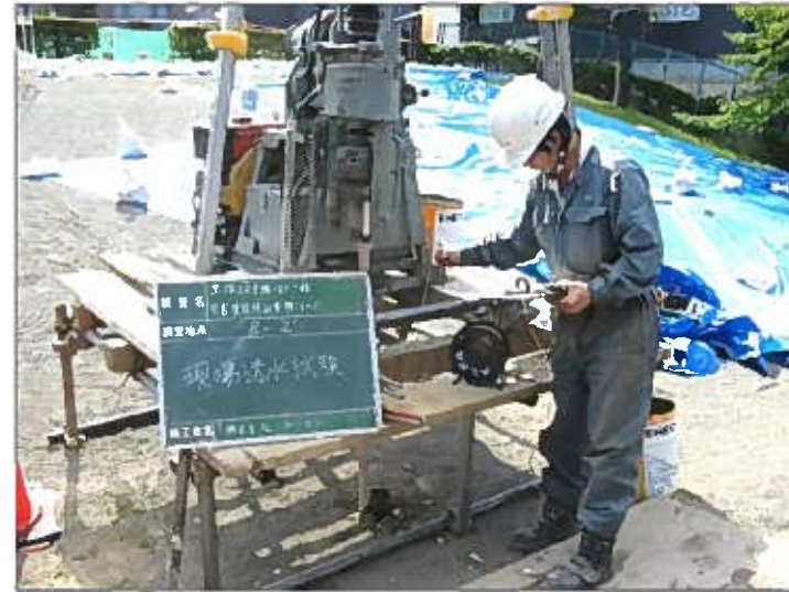
現場透水試験状況写真
