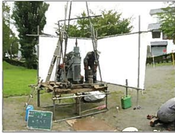
ボーリング状況写真
