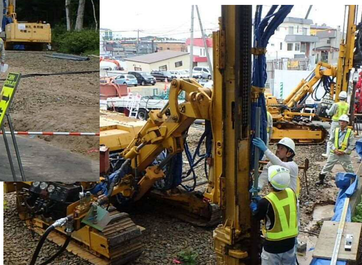
↓ 削孔を行い注入外管を挿入している状況
