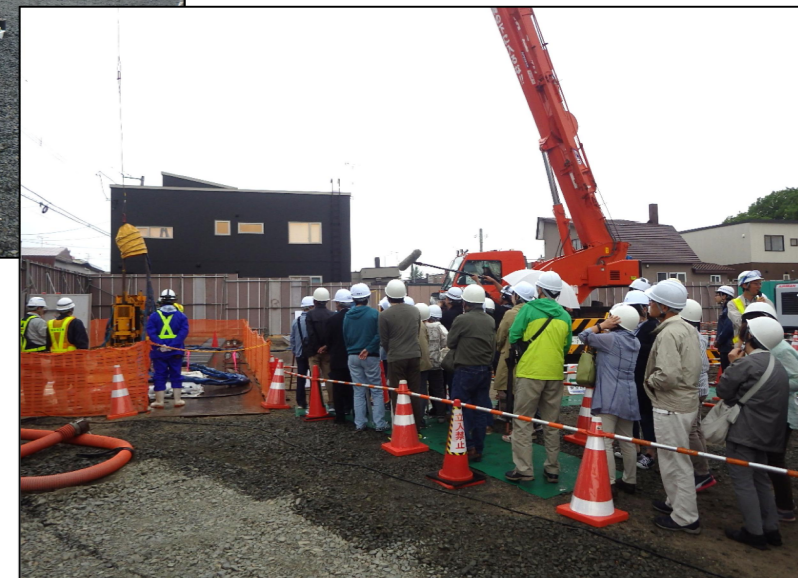
施工状況見学の様子
