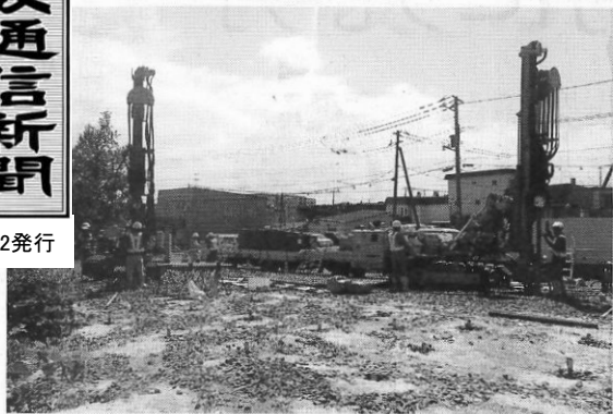
薬液注入による地盤改良を採用した
