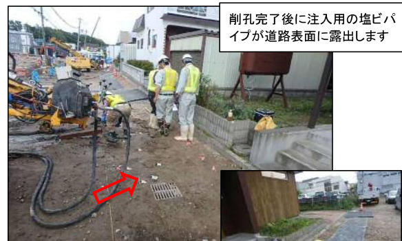
露出した塩ビパイプはプラスチック製の敷板で養生します
