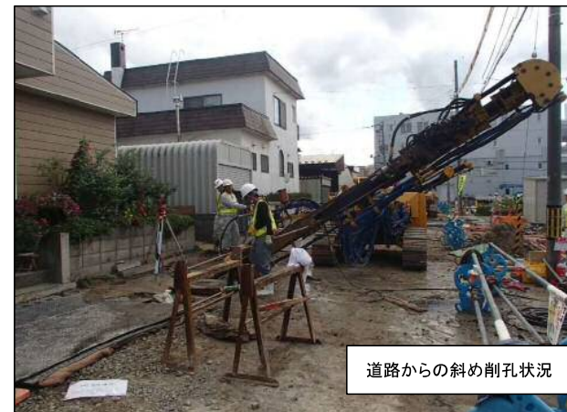
※28号線での薬液注入工施工の様子
