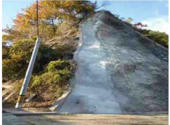
＜対策実施後：損傷部分を撤去後、再吹付＞
