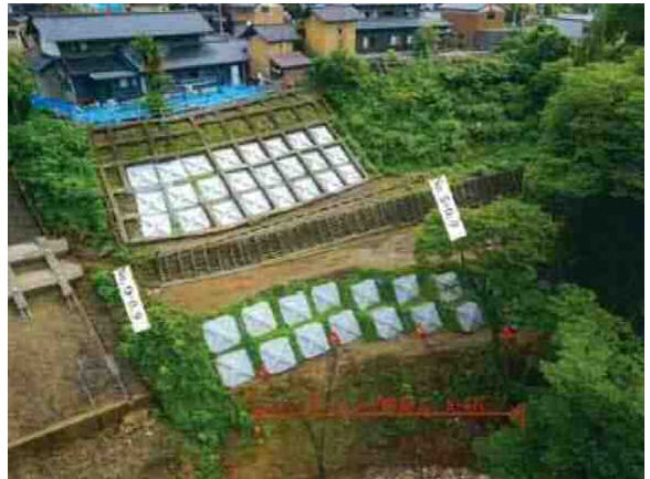
＜対策実施後：アンカー工増設＞
