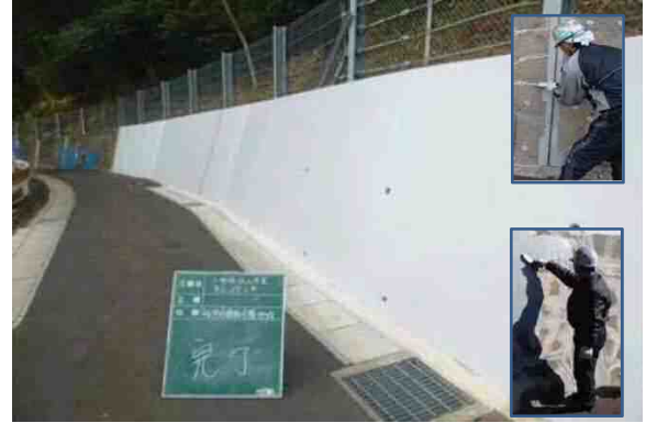
＜対策実施後：ひび割れ注入後表面被覆＞
