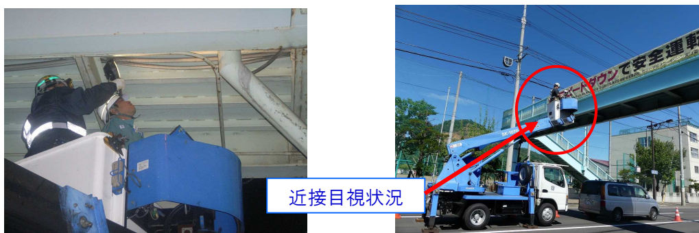
【高所作業車による近接目視点検】
