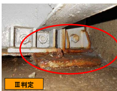
【高欄・地覆】変形・欠損：Ⅲ判定
