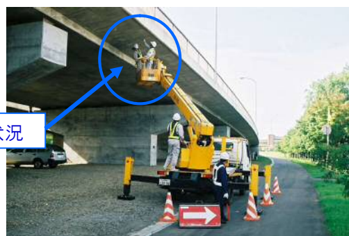
【高所作業車による近接目視点検】
