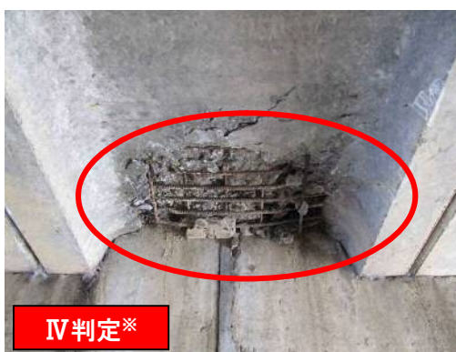
【コンクリート橋の主桁】はく離・鉄筋露出：Ⅳ判定相当
