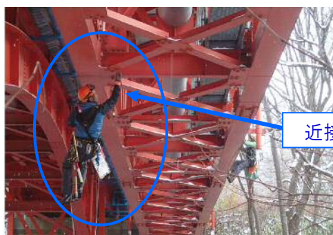
【ロープを用いた近接目視点検】
