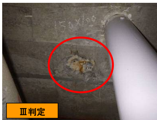
【支承（鋼製）】腐食：Ⅲ判定
