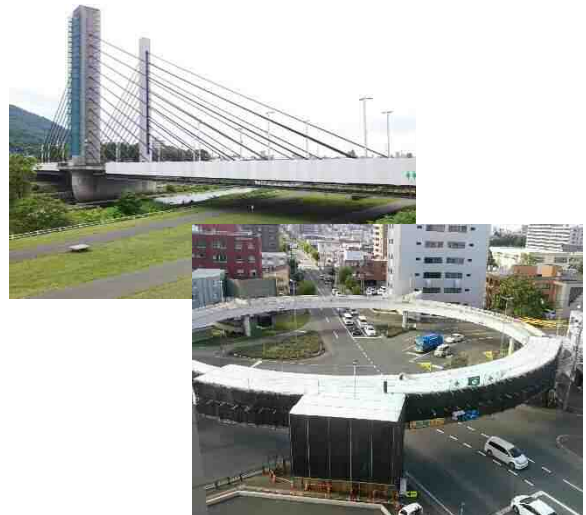
図 10 補修工事状況
