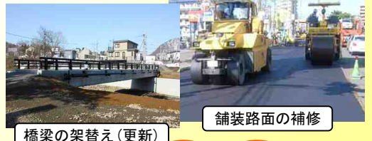
橋梁の架替え(更新)
