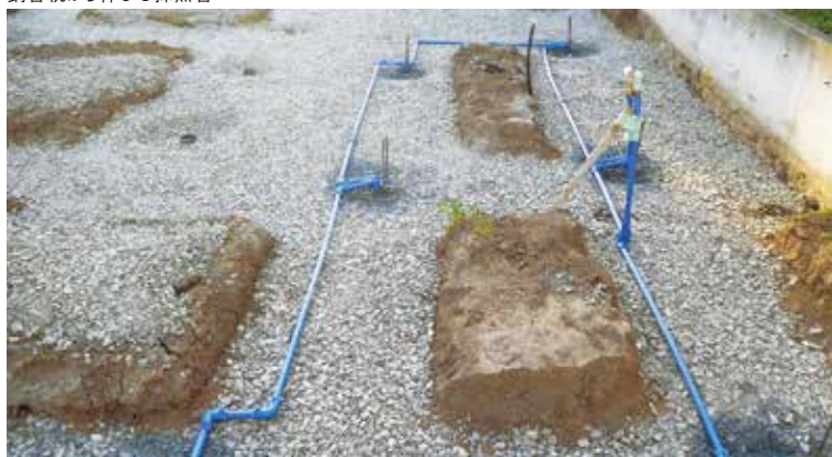
鋼管杭から伸びる採熱管
