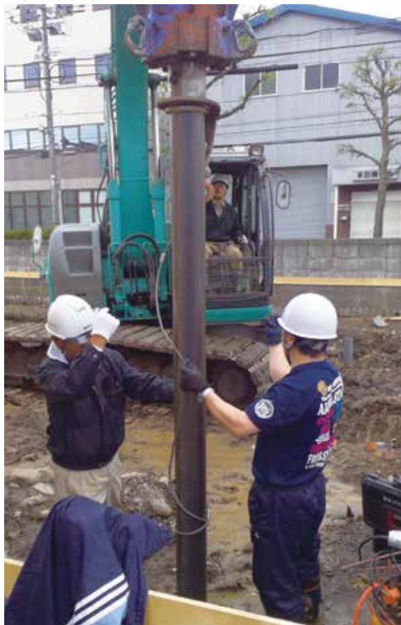
地中に鋼管杭を打ち込む
