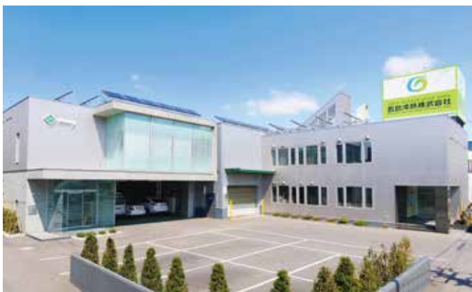
環境に配慮し、社屋にもソーラー発電や融雪電力、雪冷房を採用
