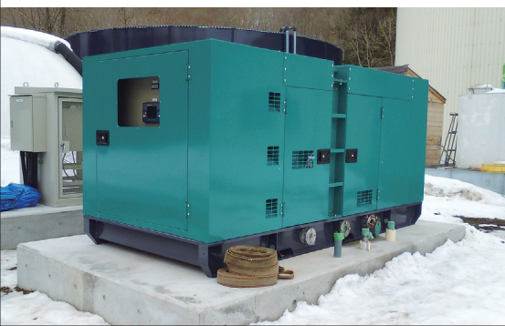
韓国KEC社のバイオガス発電機を導入
