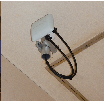
ホテルのロビーでは深夜作業が一般的だが、コスト上昇や工程延長を回避するため無線化を選択
