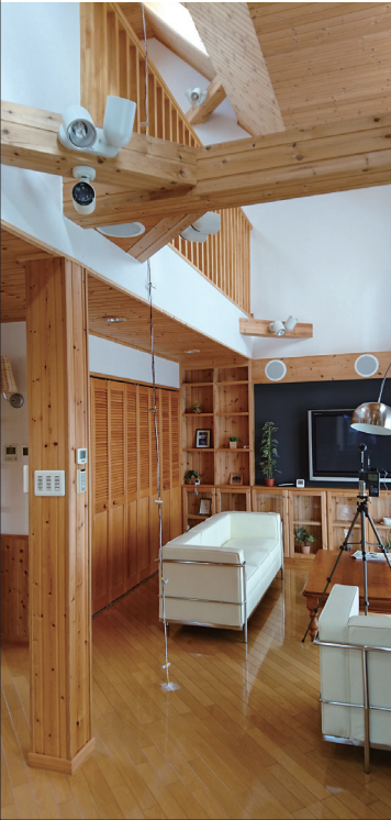
吹き抜けのリビングで温度分布を計測
