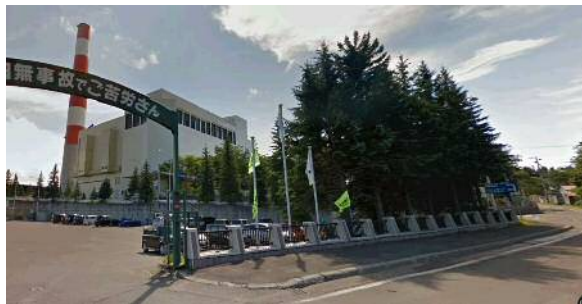
駒岡清掃工場
