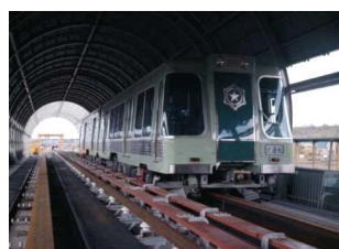
地下鉄建設(1970年)
