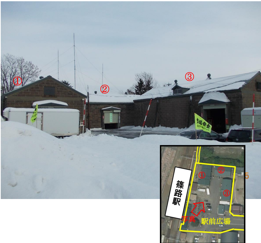
《参考写真（倉庫）》
