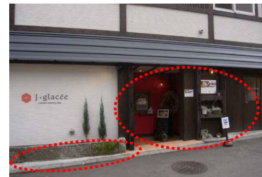
建築物の低層部に石や木などの自然素材を使用している例
