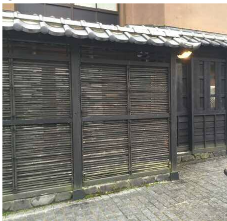
建築物の付帯設備を柵で目隠している例
