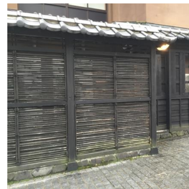
建築物の付帯設備を柵で目隠している例
