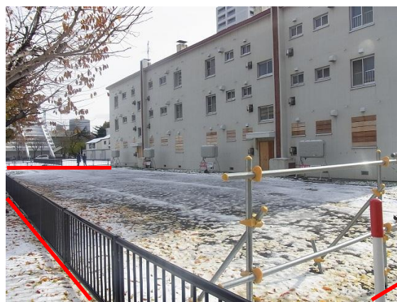
写真②：西側道路より計画地を南東に望む
