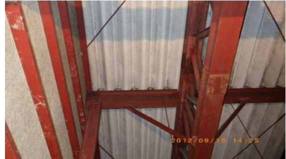
屋根用折板裏石綿断熱材
