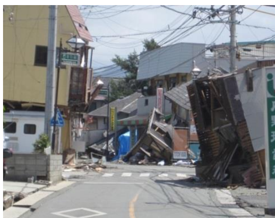
損壊建物(地震)
