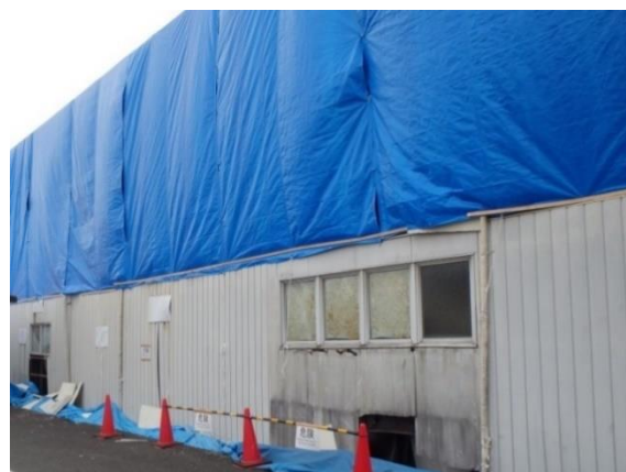
応急飛散防止措置の例 写真:熊本県
