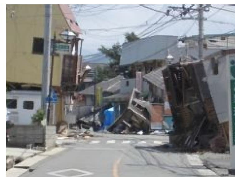
地震で損壊した建物
