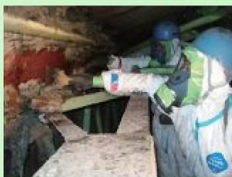
吹付け石綿の除去作業の様子
