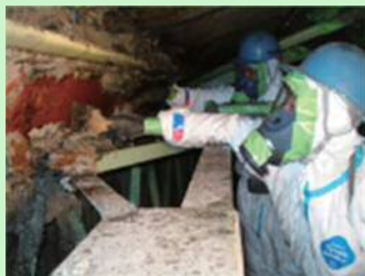
吹付け石綿の除去作業の様子
