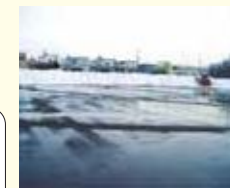
雪置き場として活用する 雨水貯留池
