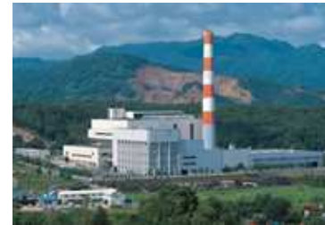
駒岡清掃工場 発電量:約2,100万kWh
