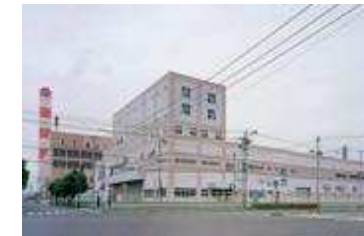
発寒清掃工場 発電量:約3,200万kWh
