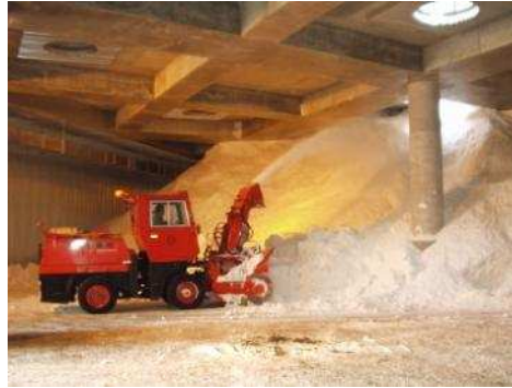
モエレ沼公園ガラスのピラミッドの雪冷熱利用(貯雪量3,160m 3 )
