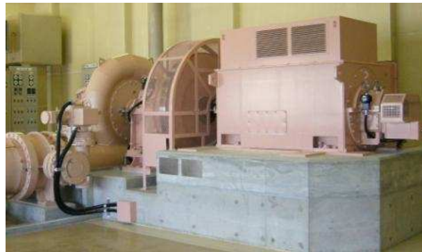
水道局藻岩浄水場の水力発電(能力400kW)
