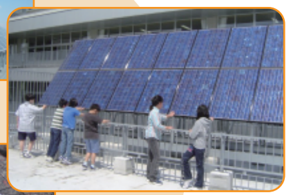
資生館小学校の太陽光発電設備
