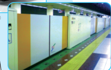
地下鉄ホーム構
