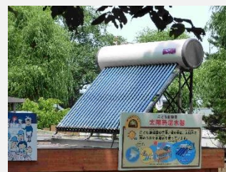
太陽熱温水器 (札幌市次世代エネルギーパーク)
