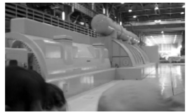
6年修学旅行～火力発電所見学
