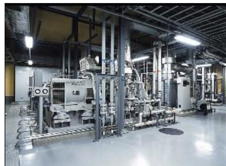
図21 コージェネレーションシステム (札幌ドーム)
