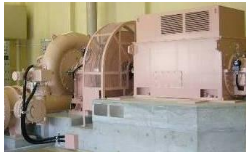
図20 小水力発電設備(藻岩浄水場)
