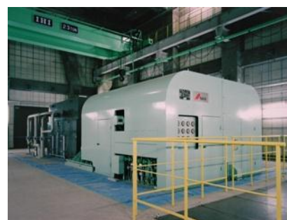
図11 蒸気タービン発電機 (白石清掃工場)
