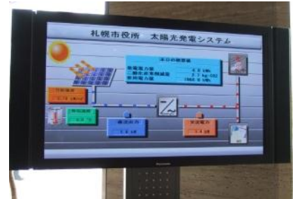
図19 太陽光パネルと発電モニター (市役所本庁舎)
