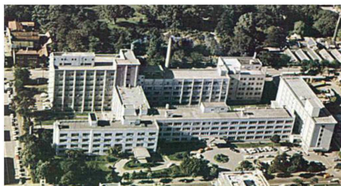
昭和31(1956)年には鉄筋コンクリート造の新本館が落成 上は昭和41(1966)年頃の空撮
