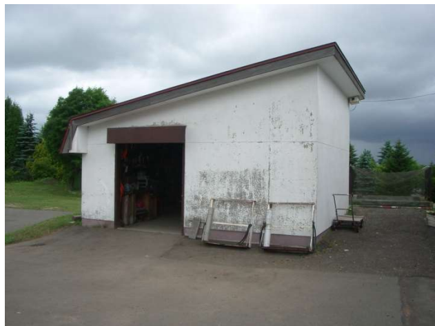
管理事務所裏側倉庫
