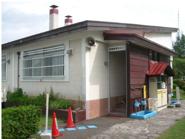
裏側から見た管理事務所入口
