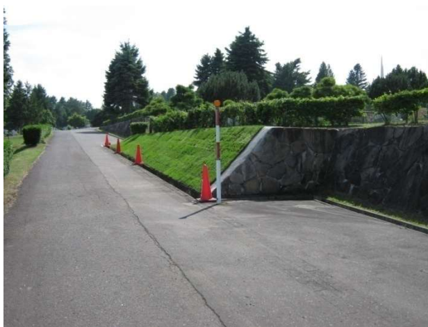
1期6号の道幅が狭くなっている園路の様子
