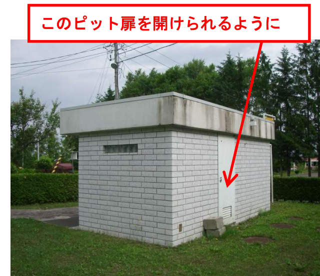
トイレ裏側の様子
