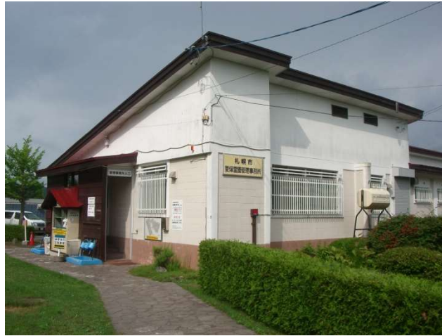
トイレ横からの管理事務所の様子
