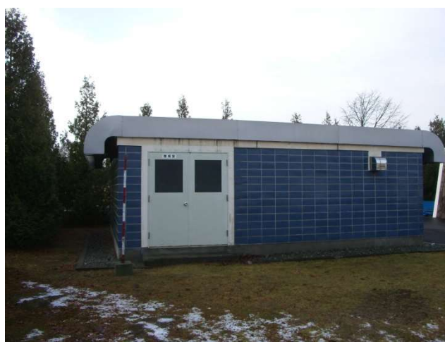
管理事務所裏側機械室
