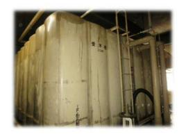
水槽の天板や金属製の補強材、組立ボルト等 の経年劣化や強度低下が原因の事故に注意 /
