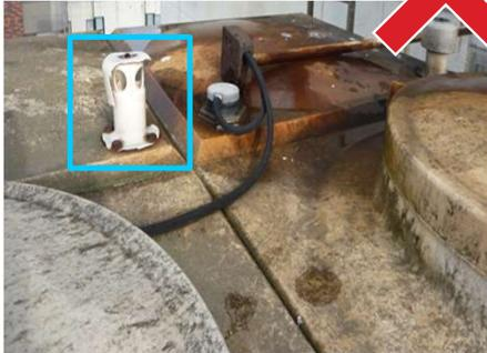
通気笠が破損し開放状態
