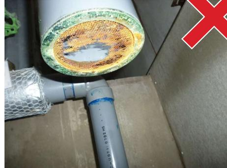
防虫網の破損
