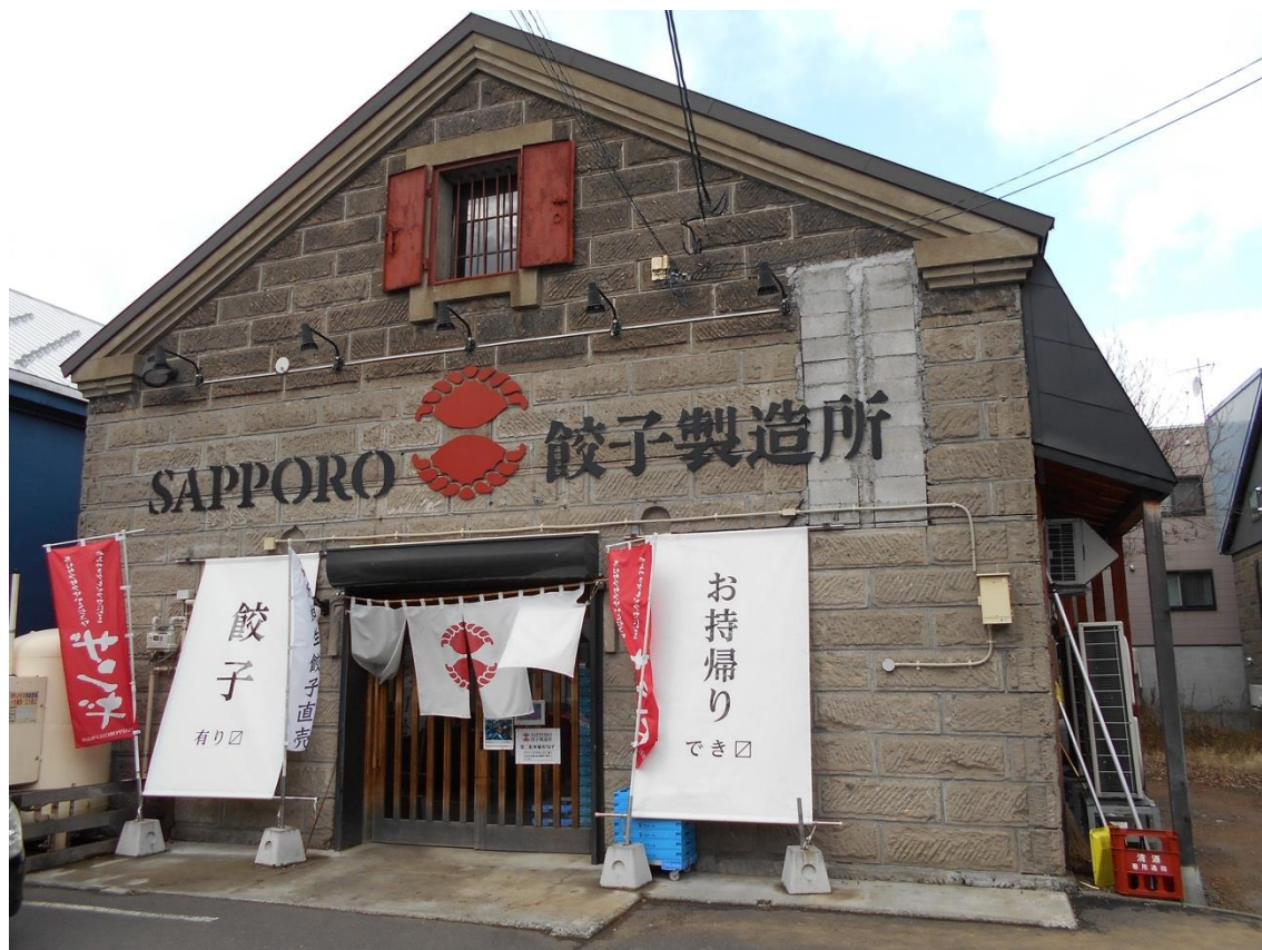
図 2 : 石造りの倉庫を再利用した食堂
