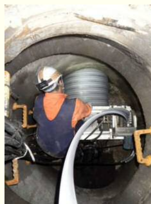
管更生工法による改築
