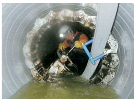
○管路の耐震化工事の様子
