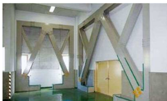
○水再生プラザの耐震補強状況
