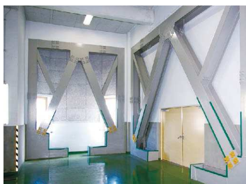
水再生プラザの耐震化
