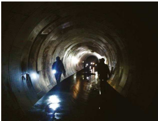
豊平川雨水貯留管
