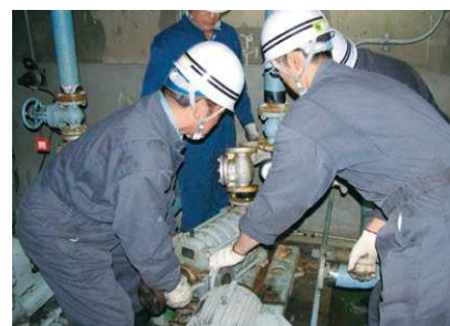
処理施設の保守点検
