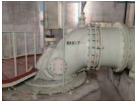
ポンプ本体（沈砂池）
