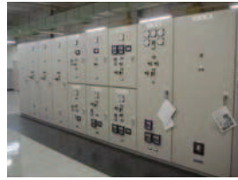
受変電設備（電気室）
