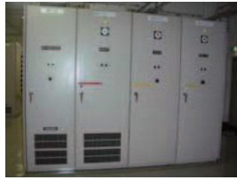
配電盤（電気室）
