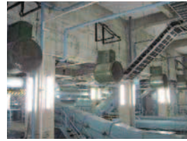
換気設備（水処理施設）
