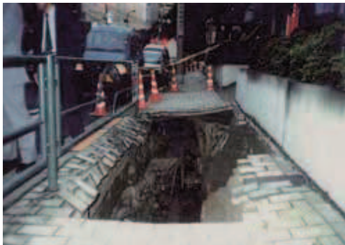
図1-7 下水道本管起因の大規模な道路陥没の例（他都市）
