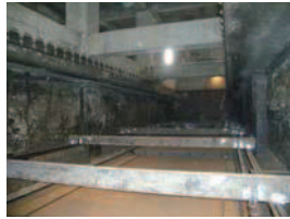
汚泥掻寄機（最初沈殿池）
