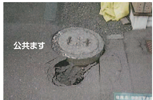
道路陥没状況
