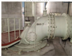
ポンプ本体(沈砂池)
