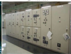
受変電設備(電気室)
