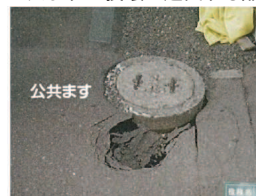
＜公共ますの損壊に起因する陥没＞
